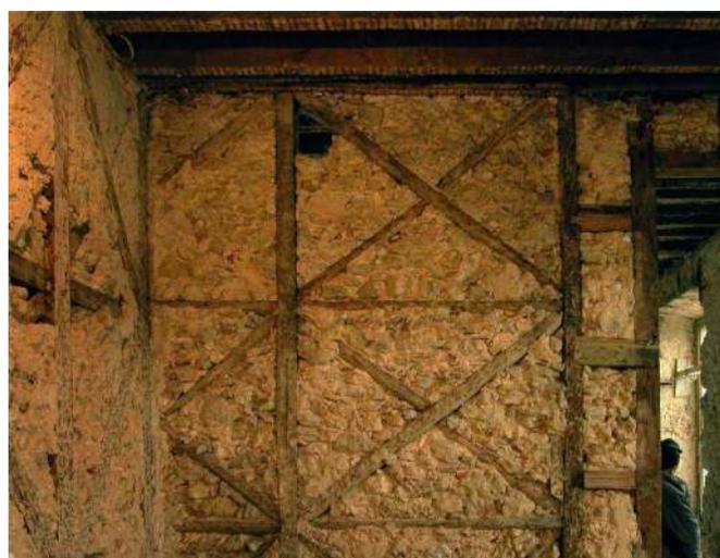
*Particolare della gabbia pombalina: si notano molto bene la struttura con i controventi diagonali (in grado di contrastare perfettamente le tipiche lesioni a taglio delle murature) e il tamponamento in muratura di pietrame*
